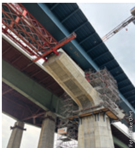
Durch das Schieben der Elemente werden die neuen Brückenteile zusammengeführt.
