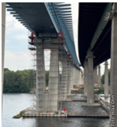
Die neuen Brückenpfeiler sind nun massiv statt hohl wie zuvor.
