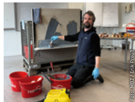
Referent Dipl.-Ing. Peter Stuckenberg führt die Sockelabdichtung mit MB 2K den Teilnehmern vor.
