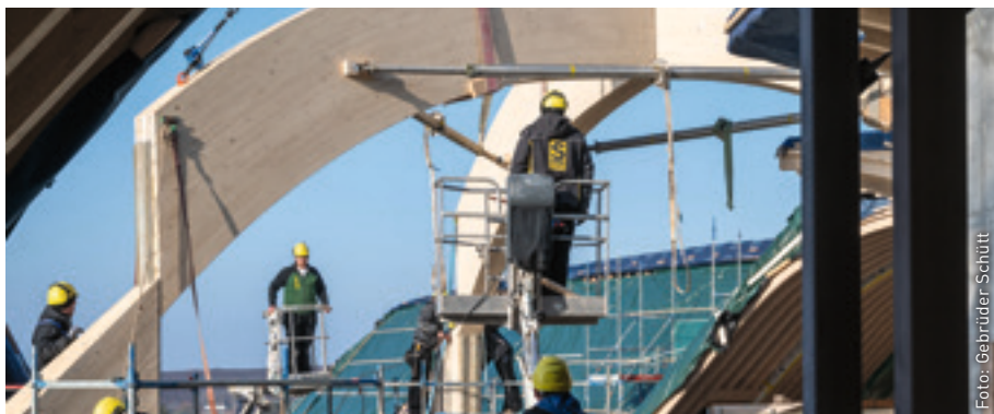
Einbau einer Binderkonstruktion in Friedrichskoog
