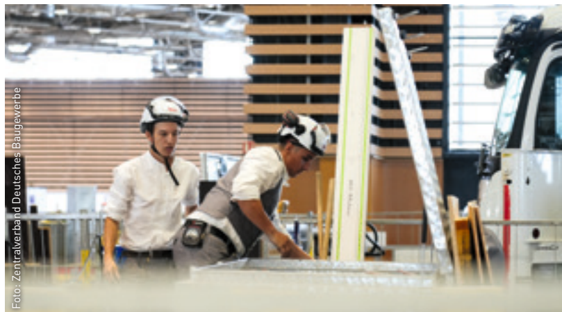
Team Stahlbeton bei den WorldSkills 2024 in Lyon
