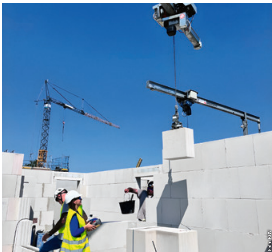
Die Innenministerin steuert das Positionieren eines Bauteils.
