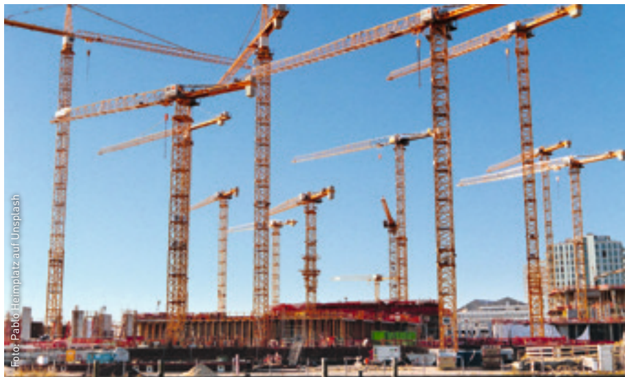
Baustelle in der Hafencity in Hamburg
