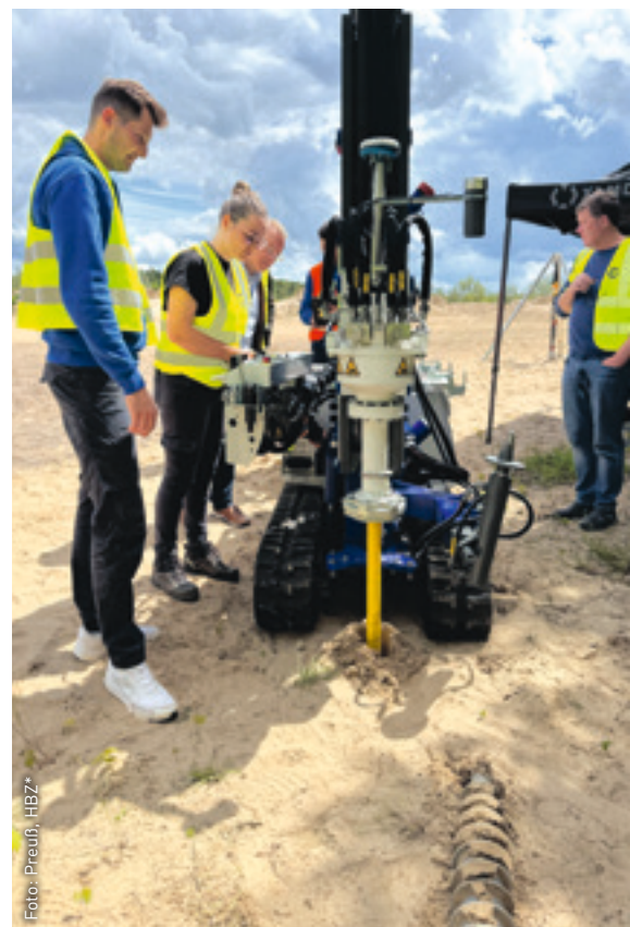
Für enge Baustellenverhältnisse ist das Raupengerät besonders gut geeignet.
