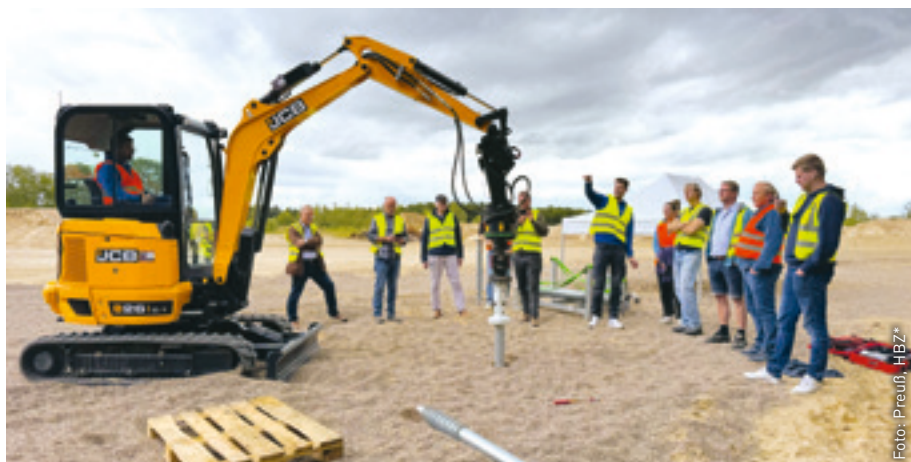
Großes Gerät ist im Einsatz, um die Schraubfundamente einzudrehen.
