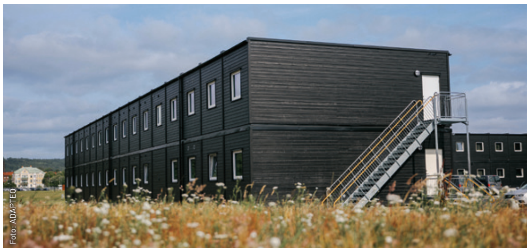
Modulbauten wie in diesem Wohncamp plant der Modulbauer Adapteo nach GCAP-Vorgaben.
