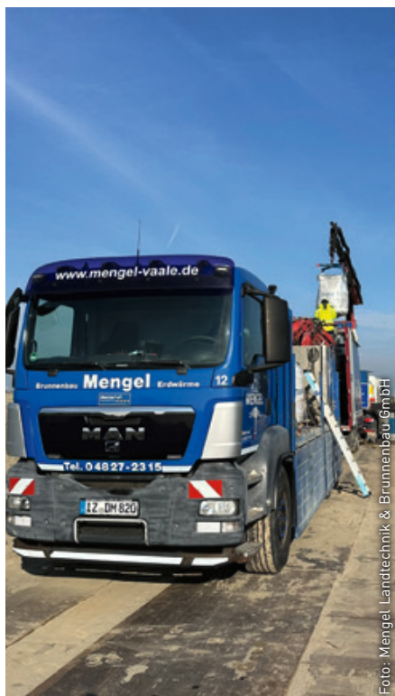
Auf der Baustelle
